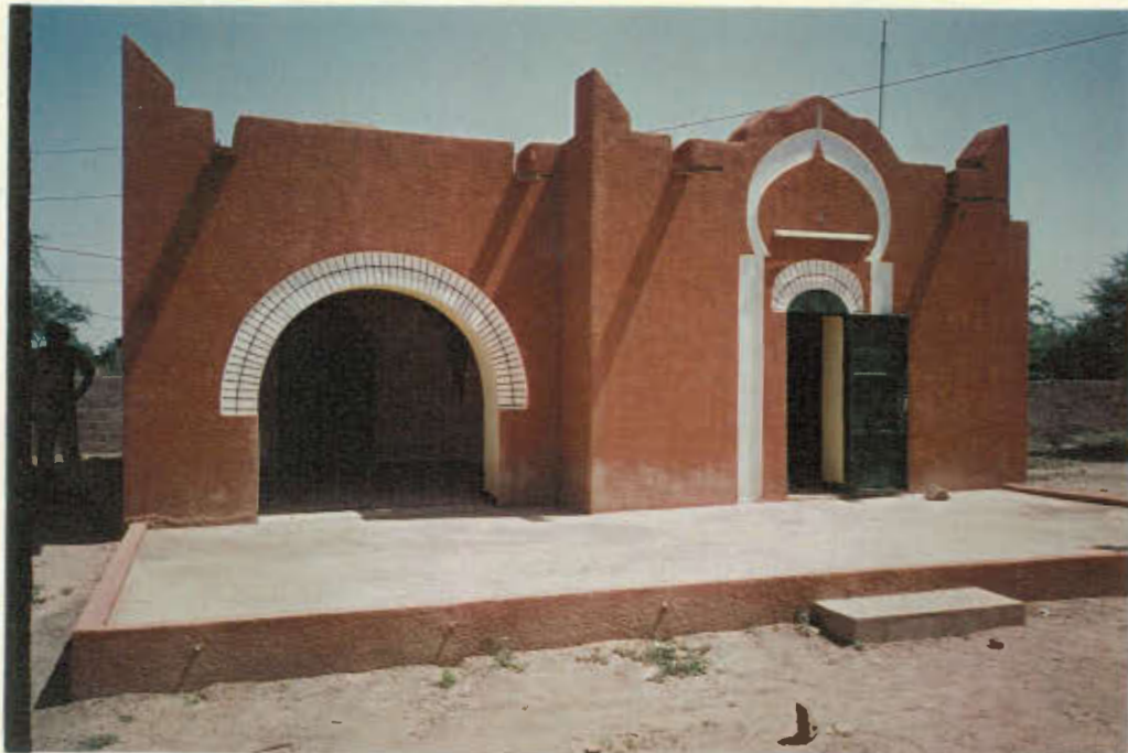
Photo No 3 : Exemple de bâtiment CSB en milieu urbain
