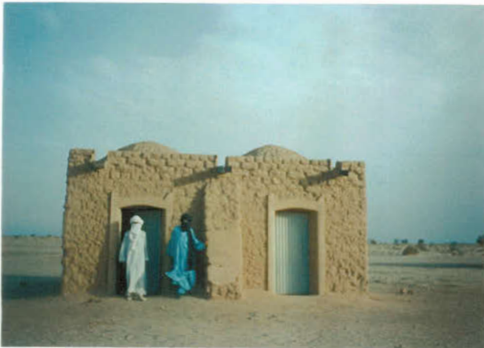
Photo No 2 : Exemple de bâtiment CSB en milieu rural
