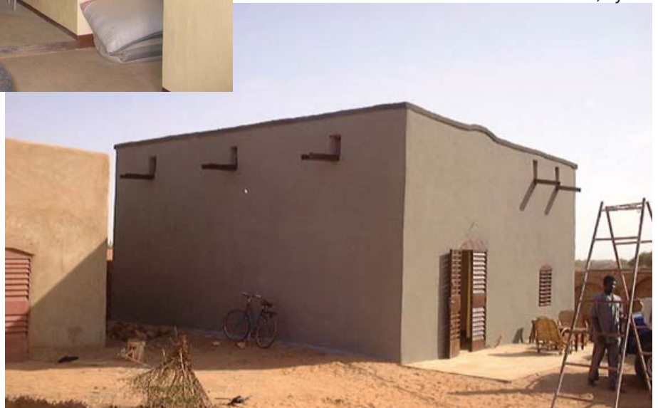
Maison Tuina - Extérieur, Djibo
