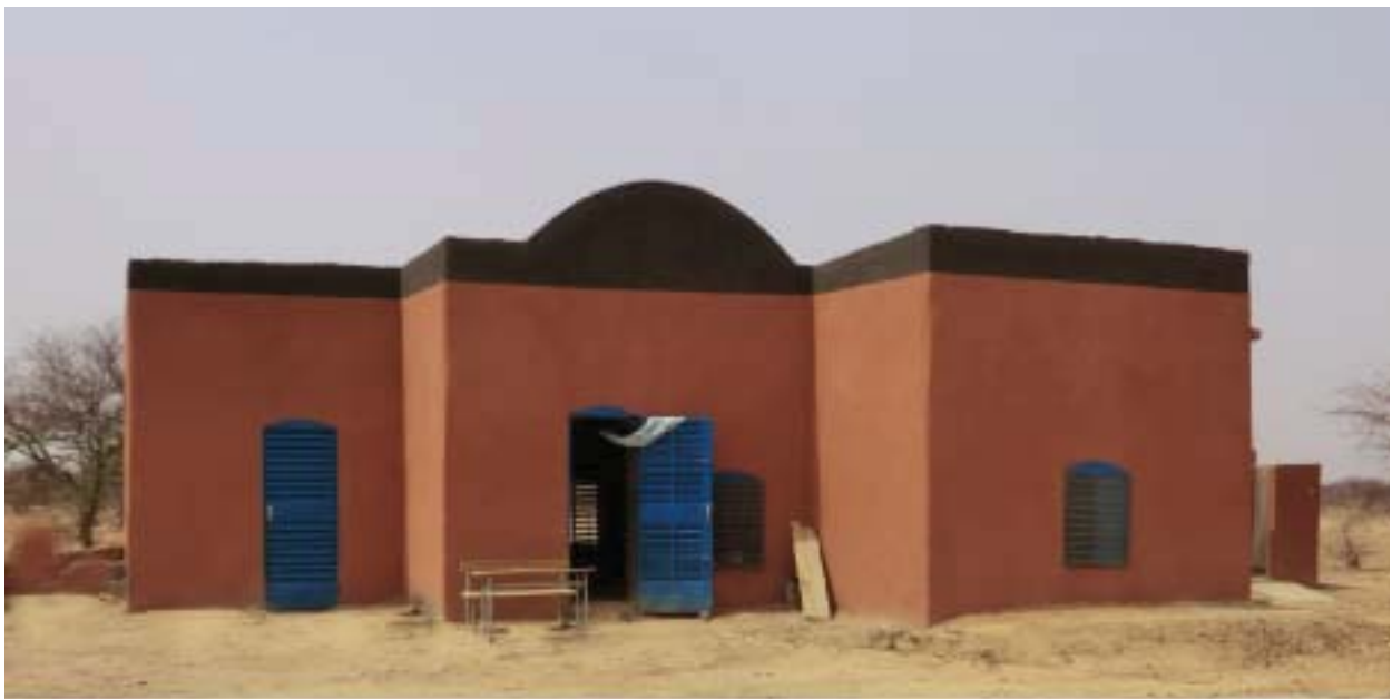
Logement d'enseignants à Gorom Gorom, T3 + cuisine.
