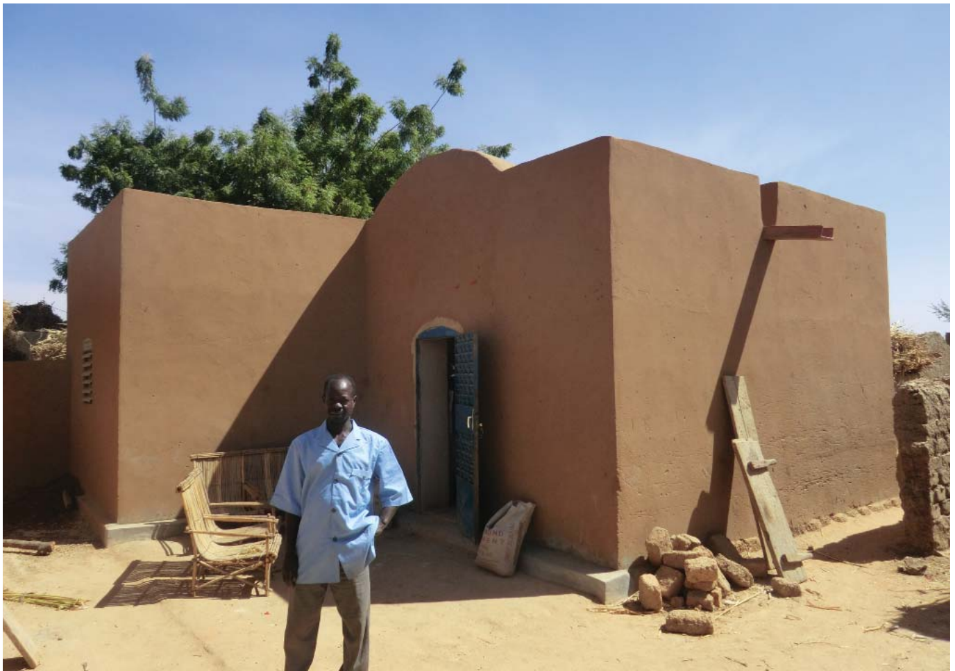
Youma Karim, maçon de Kelbo, devant sa maison T3 en Construction sans Bois. avec carrelage au sol, produit par les femmes potières du village. Les maçons et les femmes potières sont tous formés par Development Workshop.
